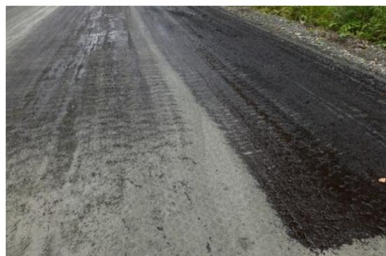
Рисунок 7 – Нанесение профилактической эмульсии на поверхность грунтовой дороги в ОАО «Святогор» при обеспыливании покрытия (слева), качество обработки с расходом 0,5 и 1 л/м<sup>2</sup>(справа)
